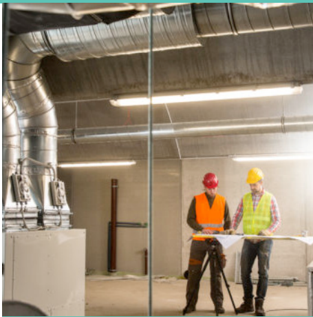
Julien, 31 ans INSTALLATEUR EN GÉNIE CLIMATIQUE
