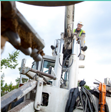
Medhi, 19 ans MONTEUR DE RÉSEAUX ÉLECTRIQUES
