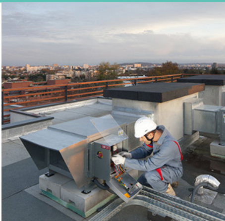
Ludovic, 35 ans TECHNICIEN DE MAINTENANCE EN GÉNIE CLIMATIQUE
